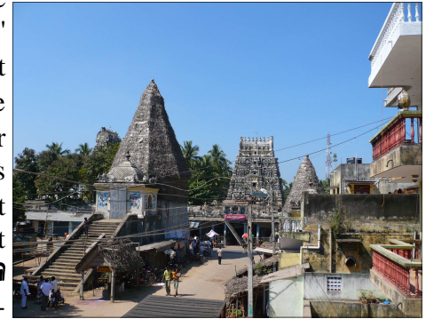
Temple de Villenour (Photo M.Gobalakichenane, 2006) (le char à l'abri au premier plan, le gopuram principal de l'est au centre de la photo et le gopuram du sud visible à gauche du char)
